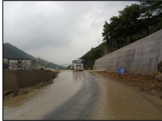
洒水车洒水降尘
