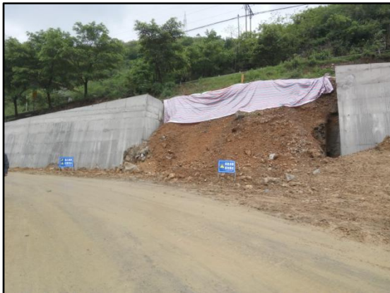
临时遮盖措施
