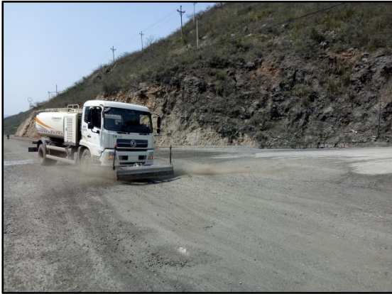
洒水车洒水降尘
