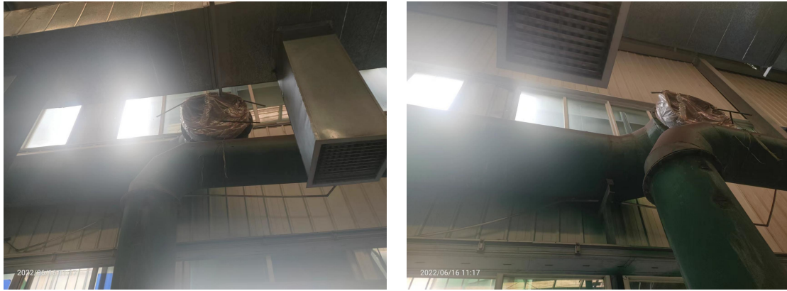
1#排气筒隔断情况
